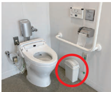
多目的トイレに設置のサニタリーボックス
