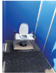
マンホールトイレ
