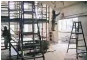
改装中の多世代交流カフェ(子ども食堂実施場所)
