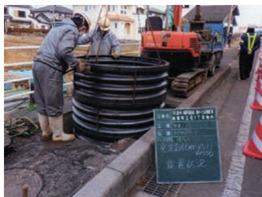
岐南町内の下水道整備工事
