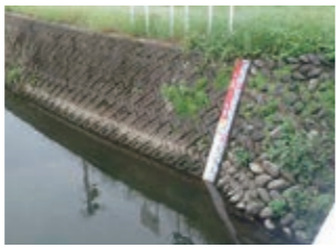
早期河川改修が望まれる
