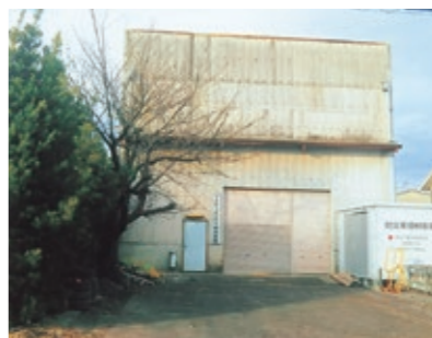
先送りされた事業 現在の防災倉庫
