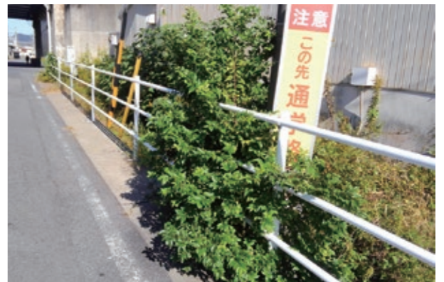
雑木が生い茂る排水路
