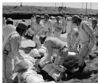
▲岐南西水防団（月の輪工）
