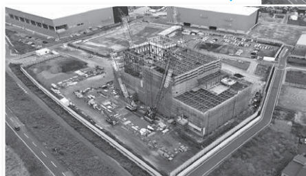
◀R7.9 外装・内装工事 プラント機器搬入据付
