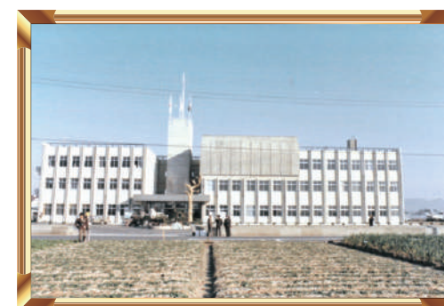
旧庁舎外観(昭和46年竣工)
