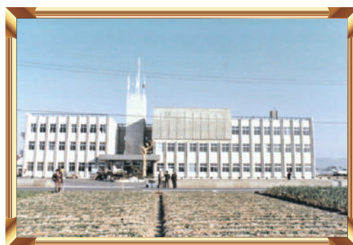
旧庁舎外観(昭和46年竣工)
